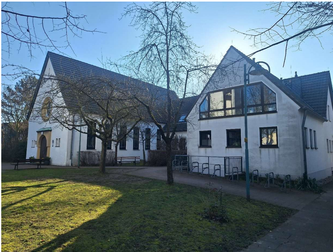
Auferstehungskirche mit Gemeindezentrum
